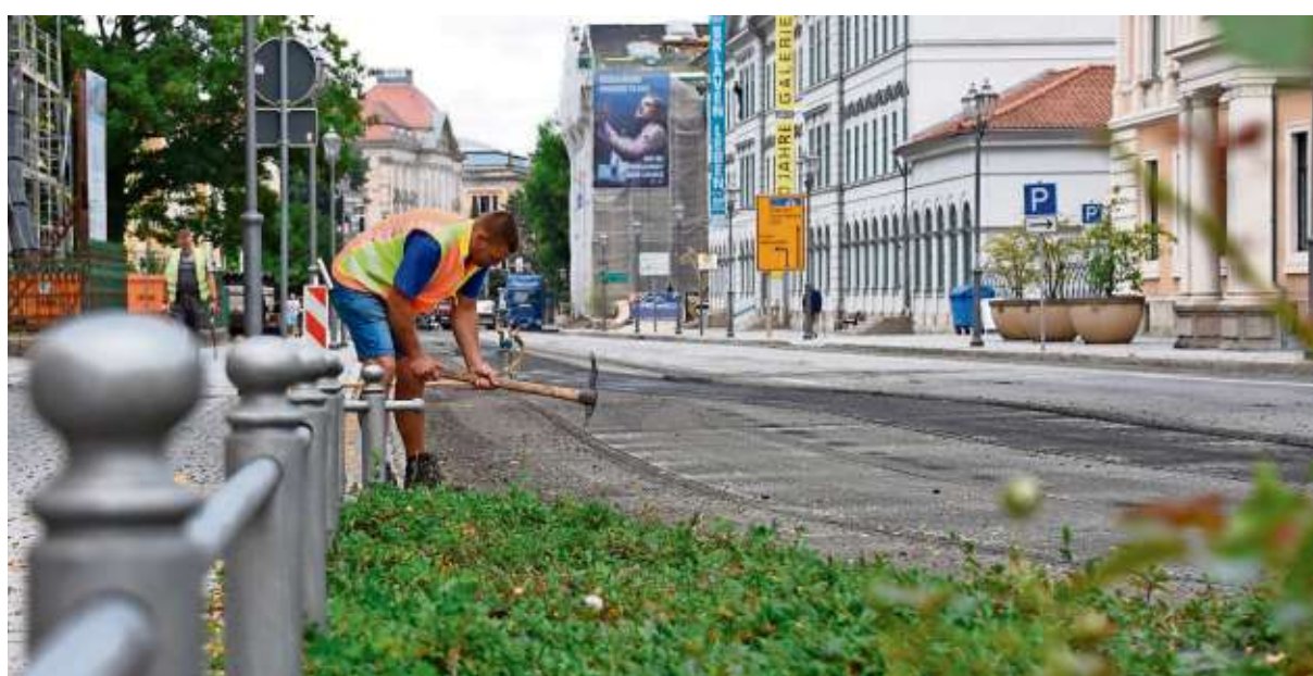
Bauarbeiter der Weimarer Firma Eurovia sanieren die Meiningener Bernhardstraße bis Anfang September. Foto: Markus Kilian
